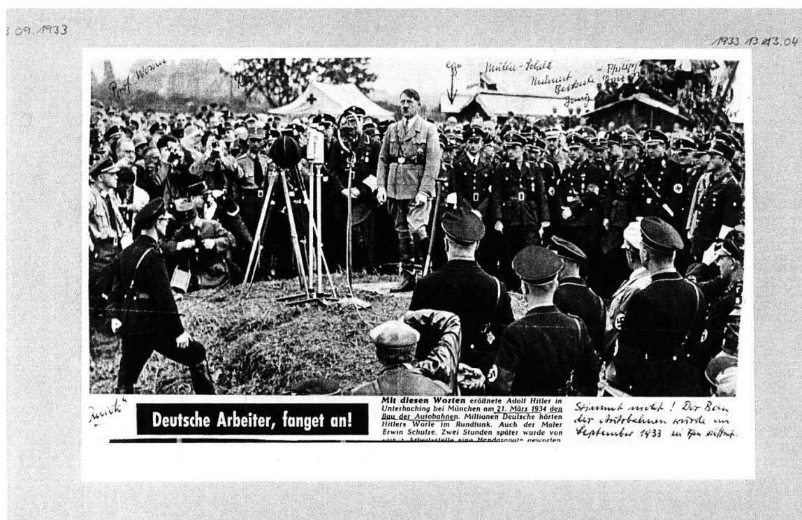
Figure 26. Coupure de presse rectifiée et image médiatique type. Cette coupure de presse indique que la photographie a été prise lors de l'ouverture du chantier de la Reichsautobahn le 31 mars 1934 à Munich. L'inscription manuscrite rectifie la référence à Munich et désigne l'ouverture du chantier à Frankfort le 3 septembre 1933 comme le véritable référent spatio-temporel du document visuel. (Source : Institut für Stadtgeschichte Frankfurt/Main. )
