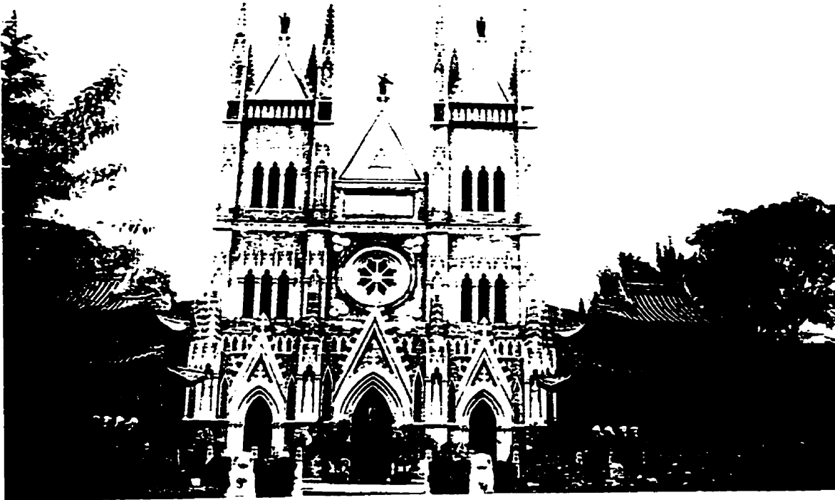
1. Église de Beitang en style gothique avec ses dépendances en style chinois à droite et à gauche Photo: Shenwen Li
